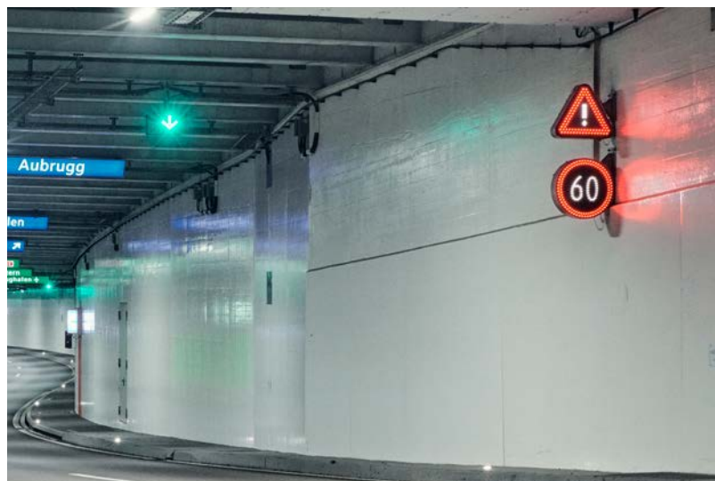
LED-Wechselverkehrszeichen informieren zuverlässig über Geschwindigkeit und Gefahren.
